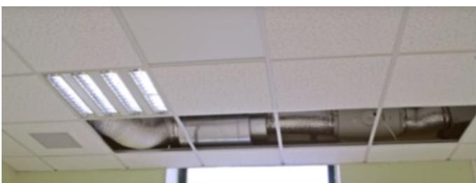
*Ventilazione controllata BMS e Demand con sensori di CO2 installati nelle aule dell'Università di Malta*
