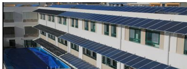
Sistema solare termico della piscina (Malta)
