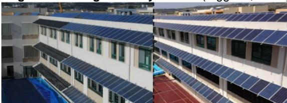
Pannelli fotovoltaici montati a parete sulla facciata sud per generare energia attraverso l'utilizzo della radiazione solare nel periodo estivo.
